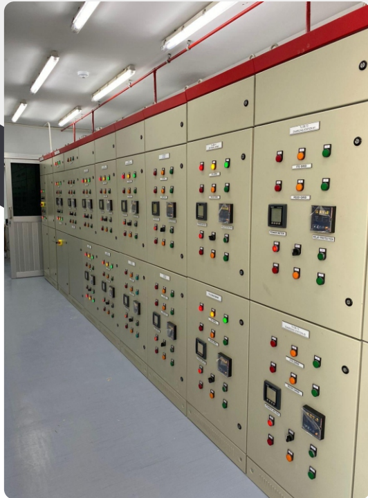
LV Switchgear
